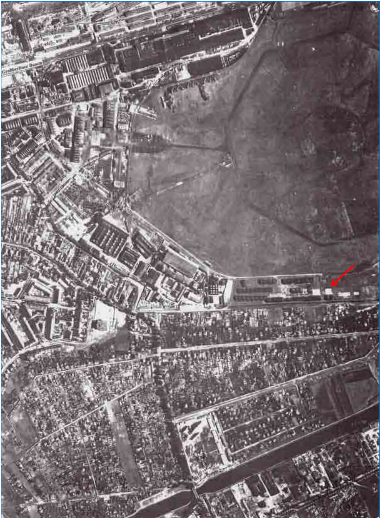
Luftaufnahme um 1940/41 vom Flugplatz Johannisthal → Die frühere Werkhalle 1 von Walther Rieseler
